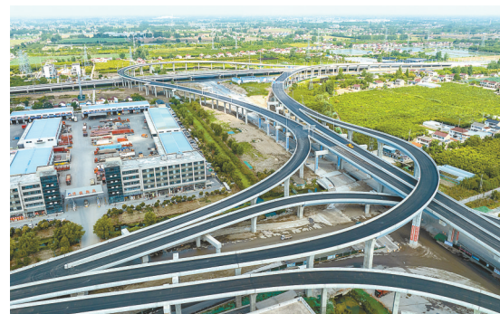
盐阜快速通道与高架四期互通枢纽
