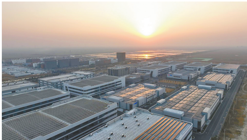
滨海片区配套产业园(屋顶光伏)(受访单位供图)
