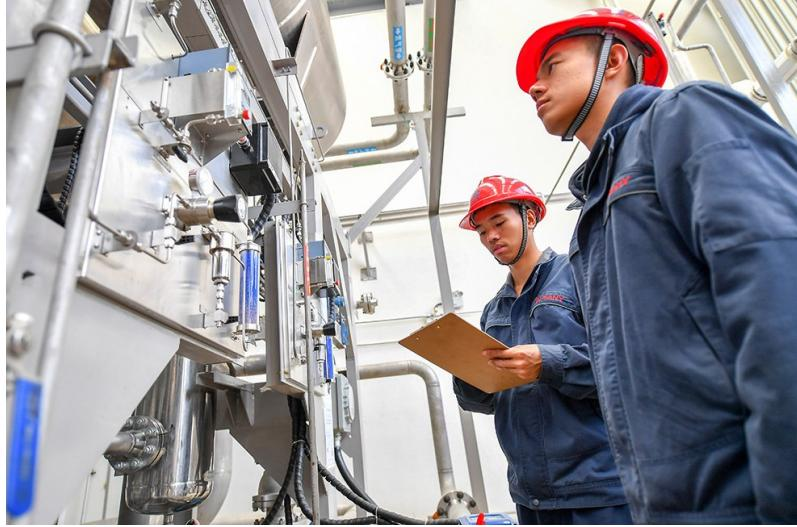
加氢一体站,工作人员在制氢区巡检。近日,位于湖南长沙经开区的三一绿电制氢加氢一体站建设完成,具备基础服务能力。该站点是2000公斤级绿电制氢加氢一体站,分为制氢区、增压储存区、加氢区3大功能分区,制氢设备由三一集团自主研发,每日的制氢加氢量不少于2吨,增压储存区总储氢量超过1000公斤,可满足4台氢能源车辆同时加注氢气,每天可服务氢能源车数量超过百台。
