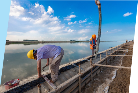
混凝土护坡施工
