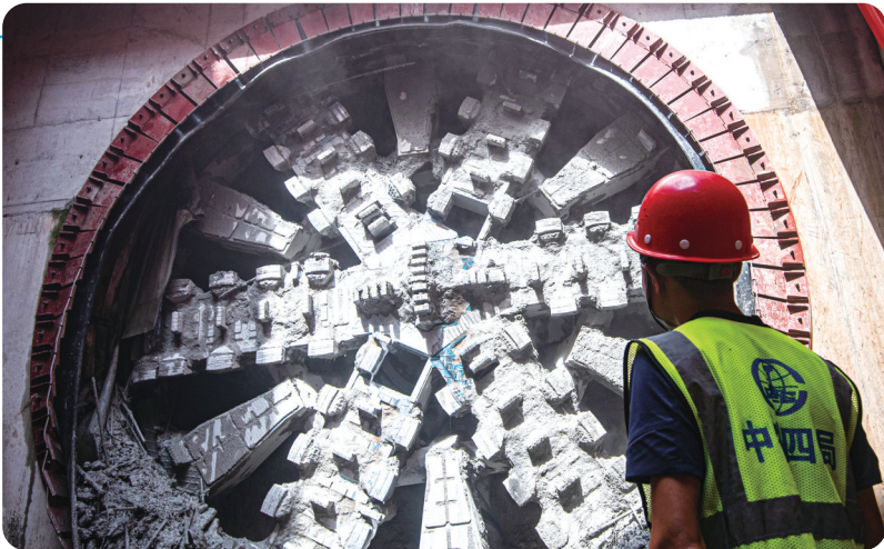
8月2日,中铁四局工人在武汉轨道交通12号线青菱站至罗家村站区间右线贯通后进行现场检查。 当日,由中铁四局承建的武汉轨道交通12号线首个盾构区间顺利贯通。该线路设站37座,串联武汉三镇成环,建成后,将提升环线客流吸引力,缓解中心城区客流压力。 新华社记者 肖艺九 摄
