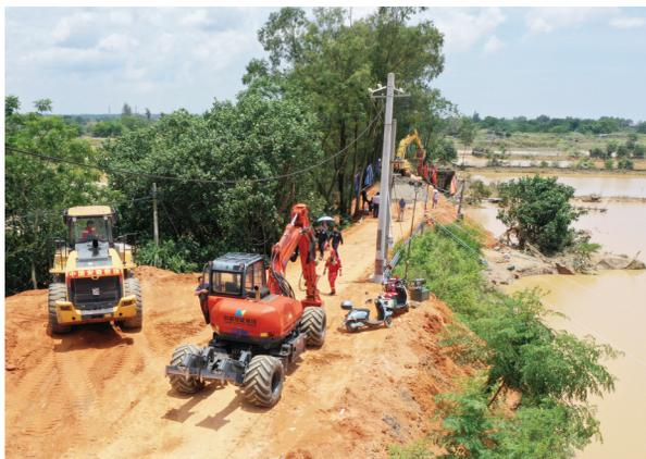
6月11日,在广西合浦县白沙镇,工人在施工修复遭洪水损毁的堤坝(无人机照片)。
