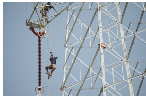
近日,500千伏徐盐、徐都线跨越滨淮高速升高改造工程现场,江苏省送变电有限公司施工人员正在加紧架设导线。 周吉成 摄
