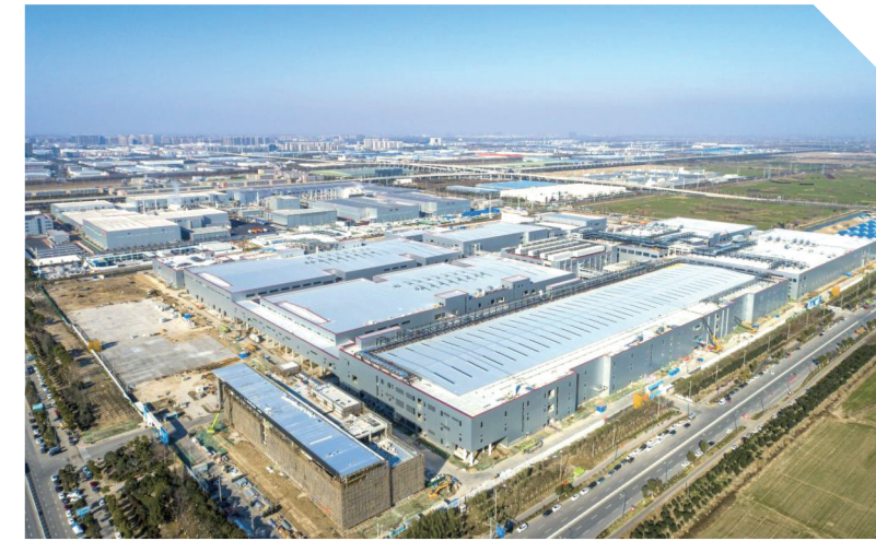
SK动力电池二期项目
