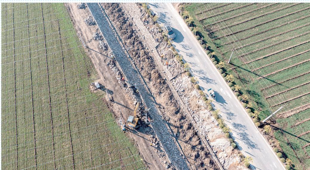
11月16日,唐山市丰南区胥各庄镇东望马台村,工人进行水渠护坡施工。入冬以来,河北省唐山市丰南区抢抓河流水位低、天气条件好的有利时机,加紧疏浚河道,加固堤坝,推进水利基础设施建设,为来年农业生产和防汛抗旱打下基础。
