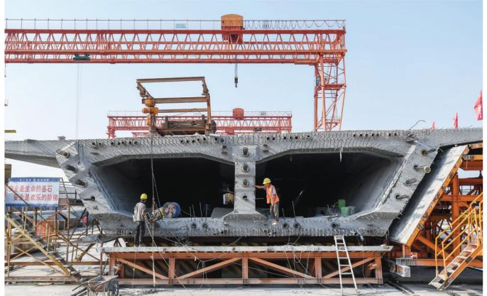
10月8日，随着第155片60米混凝土箱梁在广东中山智慧梁场完成预制，由中铁大桥局承建的深中通道全线非通航孔桥共791片混凝土箱梁预制工作全部完成。深中通道是集“桥、岛、隧、水下互通”于一体的超大型跨海集群工程，全长约24公里，其中桥梁工程长约17公里。
