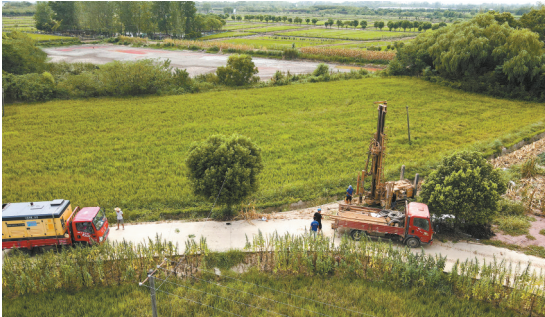
施工人员在肥西县花岗镇为种粮大户打水井(无人机照片)。
