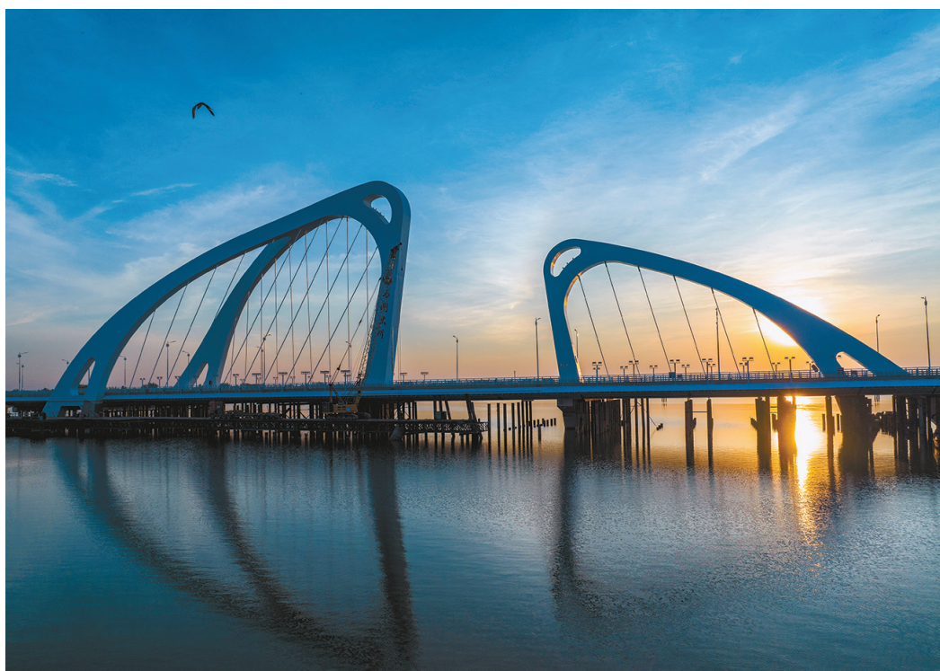
目前,江苏淮安白马湖大桥已建成,进入亮化工程调试阶段,即将通车。图为晨光中的白马湖大桥(8月13日摄,无人机照片)。
