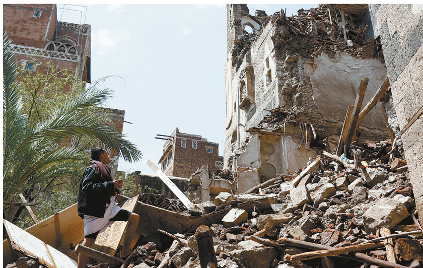
这是8月10日在也门萨那老城拍摄的受损建筑。受连日暴雨冲刷,也门萨那老城中有40余座建筑受损。萨那老城于1986年被列入联合国教科文组织世界遗产名录。 新华社发
