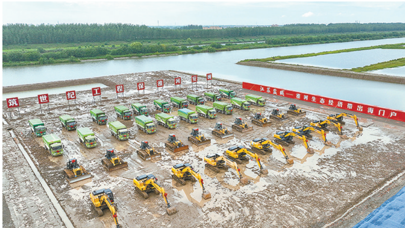
7月30日,淮河入海水道二期工程开工现场。 李思远 摄
