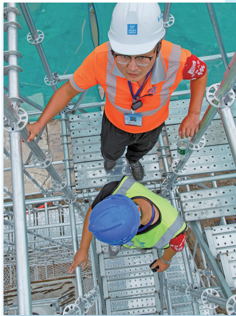
检查盖梁施工支架
