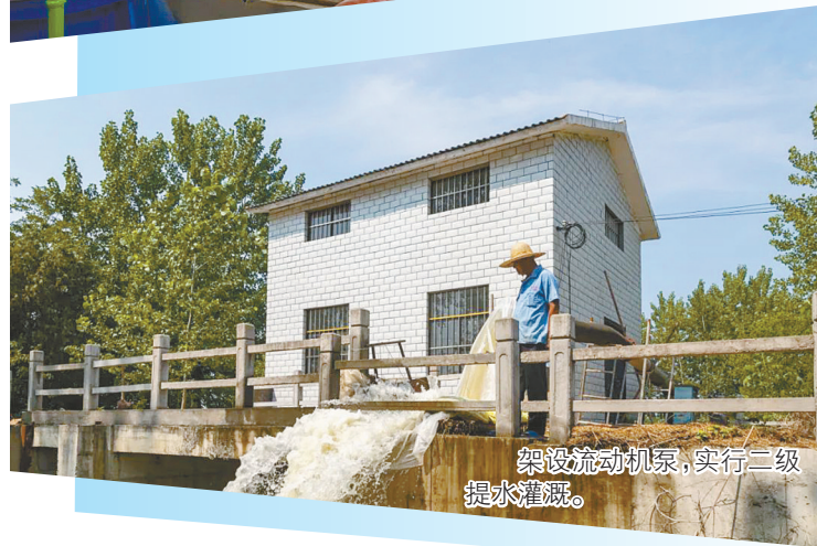
抽水站管理所工作人员加强巡视检查。
