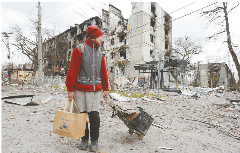
4月18日,在马里乌波尔,当地居民走过被损坏的建筑。新华社发
