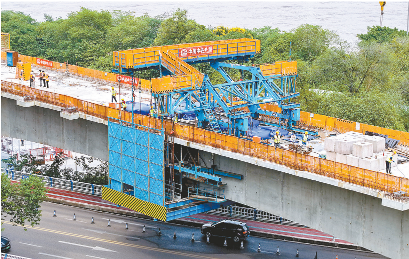
这是8月30日拍摄的成渝铁路改造工程黄桷坪双线特大桥建设施工现场（无人机照片）。
