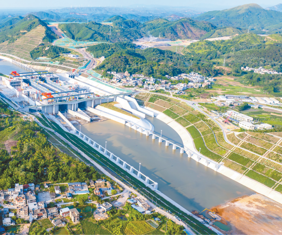
平陆运河马道枢纽充水现场(无人机照片)。新华社发 赵振宇 摄
