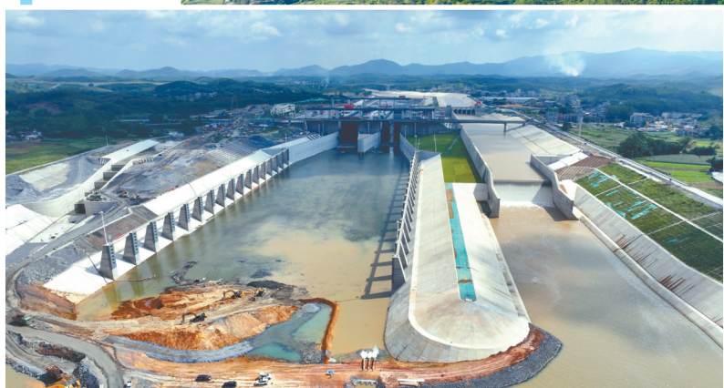
平陆运河企石枢纽充水现场(无人机照片)。新华社记者 周华 摄
