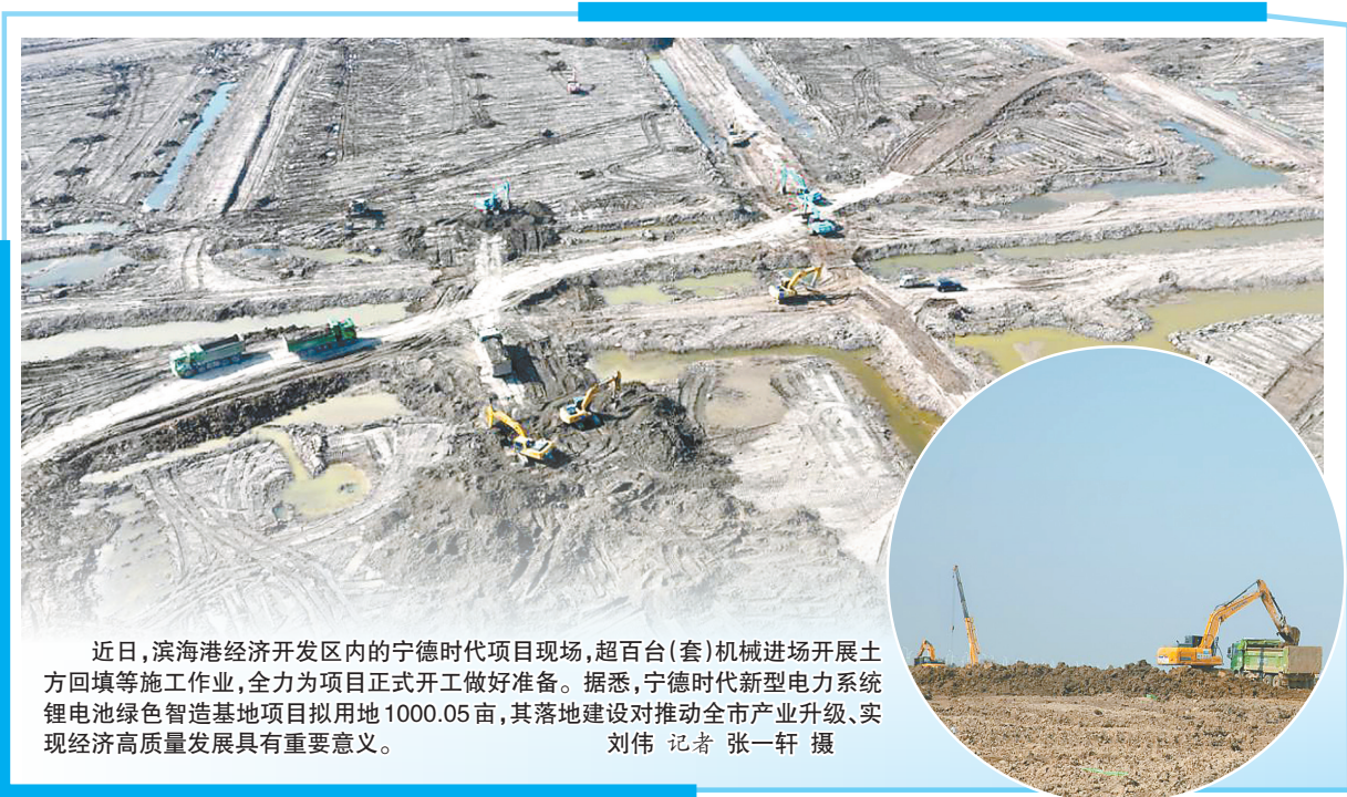
近日,滨海港经济开发区内的宁德时代项目现场,超百台(套)机械进场开展土方回填等施工作业,全力为项目正式开工做好准备。据悉,宁德时代新型电力系统锂电池绿色智造基地项目拟用地1000.05亩,其落地建设对推动全市产业升级、实现经济高质量发展具有重要意义。 刘伟 记者 张一轩 摄
