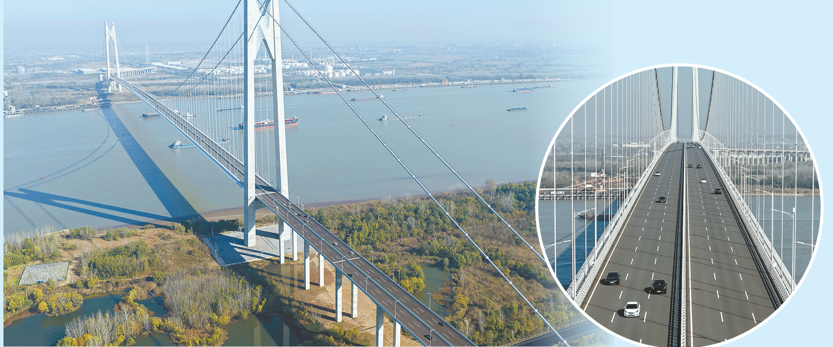
11月26日拍摄的南京新生圩长江大桥(无人机照片)。
