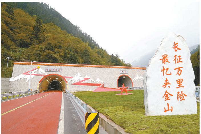
9月28日拍摄的国道351线夹金山隧道宝兴县境内入口。9月28日,由中铁十一局承建的国道351线夹金山隧道顺利建成,将于10月1日开放试运行。夹金山位于四川雅安市宝兴县与阿坝藏族羌族自治州小金县交界处,是中央红军长征翻越的第一座大雪山,海拔4000多米。夹金山隧道于2021年12月26日正式开工,主洞长9.35公里。新华社记者 胥冰洁 摄
