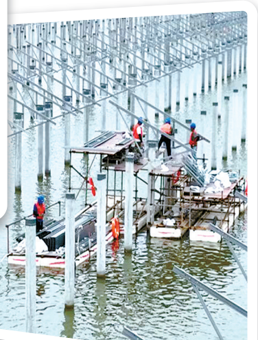
“光伏+渔业”复合开发模式——兴悦新能源420MW渔光互补发电项目正在建设
