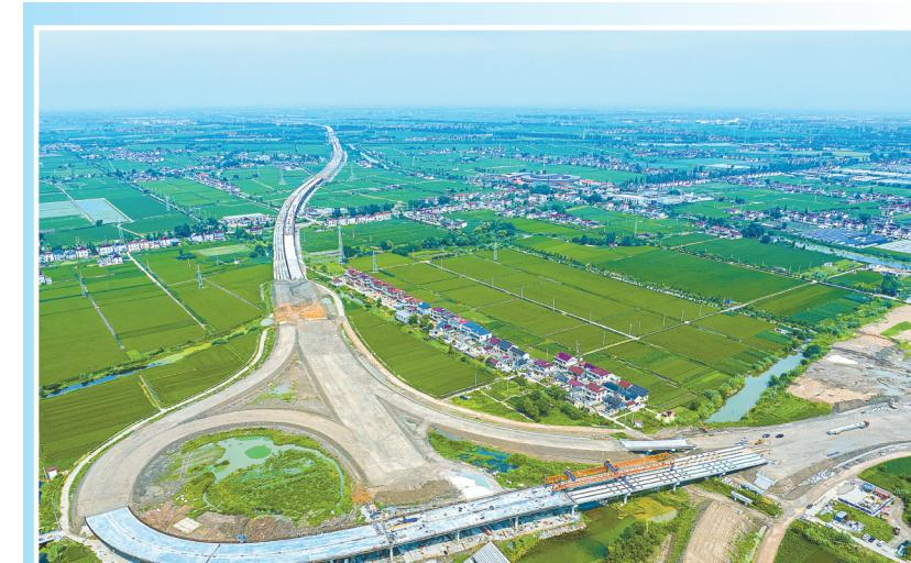
8月9日上午11点，东兴高速东台西枢纽匝道桥最后一片预制箱梁安装到位。根据设计，东台段主线和匝道、出入口道路(含涉铁部分)共有预制箱梁2175片，安装后总里程约8.5公里，预制箱梁制作和安装是项目施工中的“重头戏”，它的施工完成标志着项目全线主体结构物施工结束。
