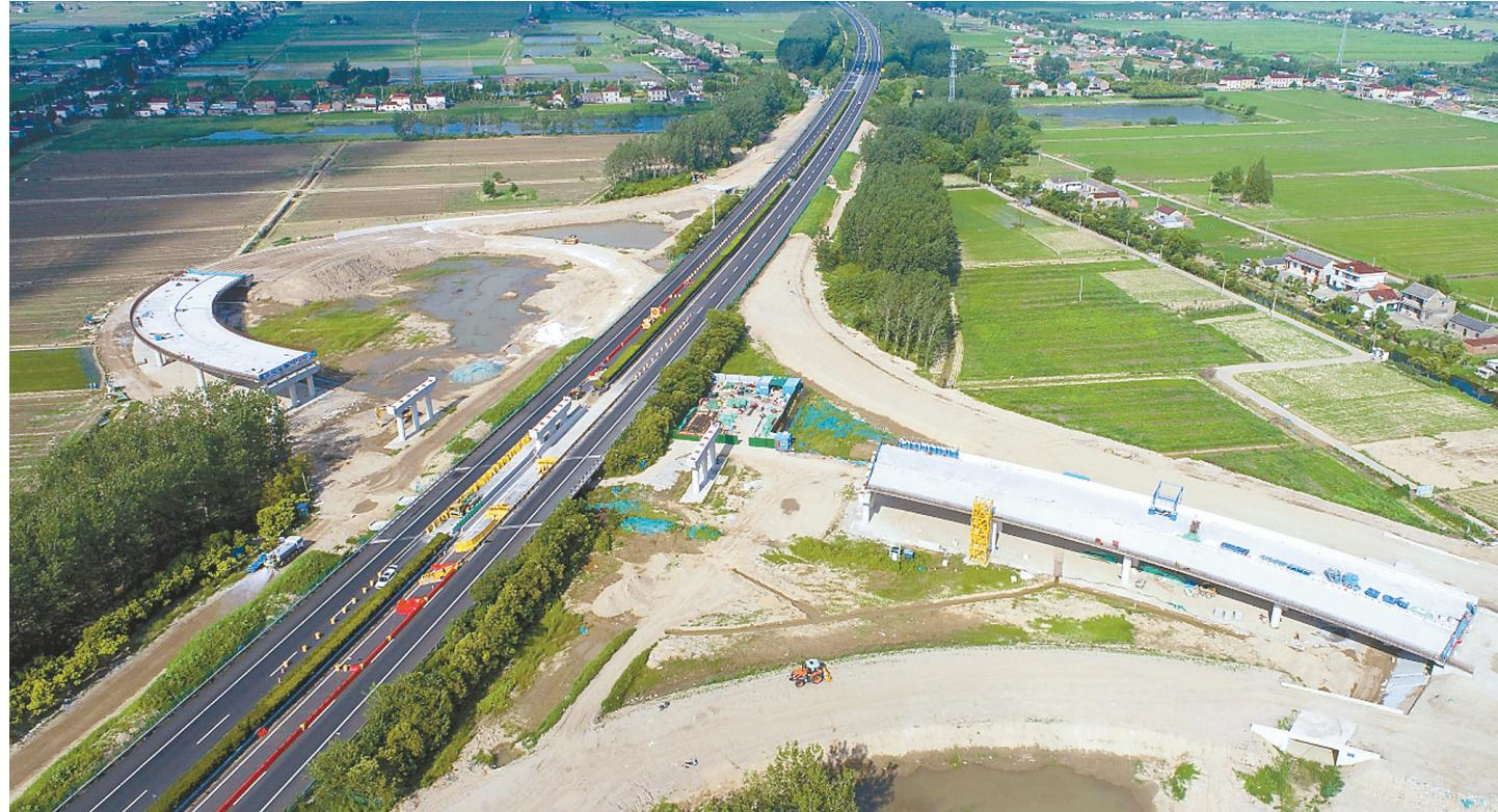
7月13日，盐洛高速公路步凤互通项目主线改造工程正加速推进。该项目主线改造范围全长1.014公里，新建匝道全长2.243公里，全线设置桥梁3座、收费站1处，目前路基工程已完成80%，收费站主体将于8月底完工。预计8月份完成桥梁主体结构跨线贯通，年底全部建成通车。
