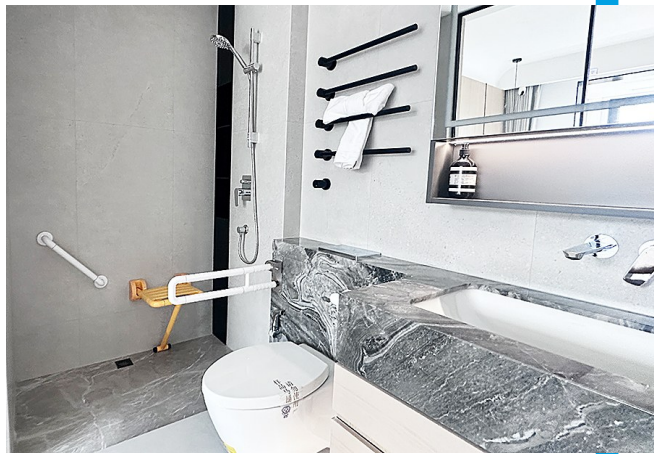
在山东淄博金城荣基·臻岳小区,样板房内助老扶手已安装完毕。
