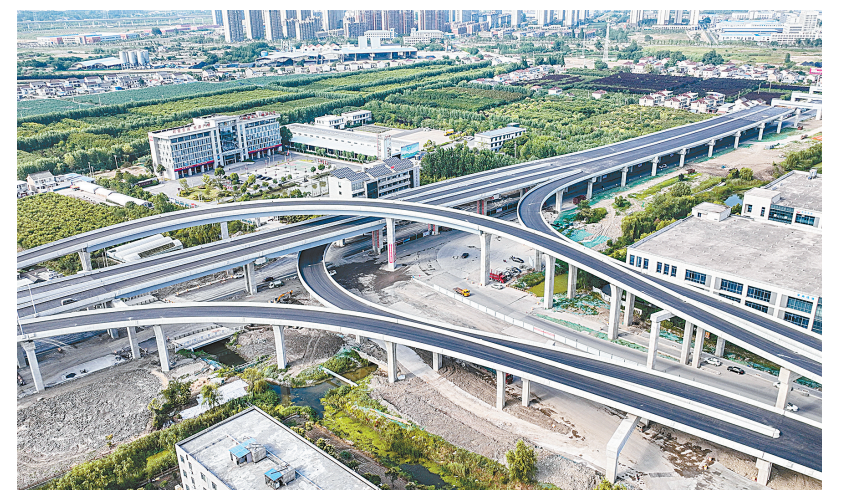
新业路高架桥
