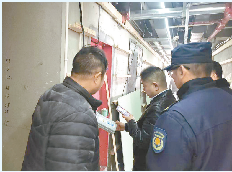
本报讯(高美)连日来,盐南高新区科城街道综合行政执法和应急管理办公室聚焦辖区商铺装修领域,聚力排查整改安全隐患,确保商铺安全运营,进一步提升商铺安全管理水平。
