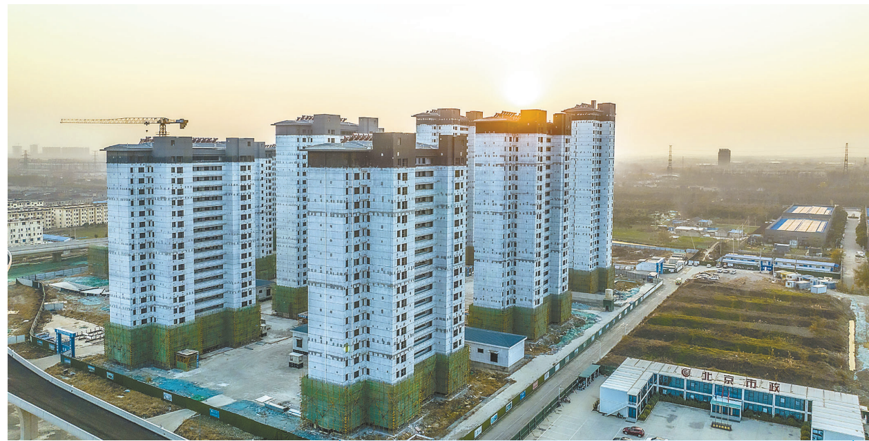
住有所居，安居宜居。12月18日下午，在盐都区张庄街道的康庄雅苑安置房项目工地，工人正在对建筑外墙进行施工。该项目于2023年9月开工，当前建设进度为完成主体结构，外墙保温，工期截止时间为2025年5月。 记者 王焱 摄
