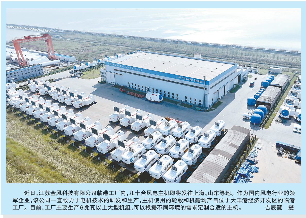
近日,江苏金风科技有限公司临港工厂内,几十台风电主机即将发往上海、山东等地。作为国内风电行业的领军企业,该公司一直致力于电机技术的研发和生产,主机使用的轮毂和机舱均产自位于大丰港经济开发区的临港工厂。目前,工厂主要生产6兆瓦以上大型机组,可以根据不同环境的需求定制合适的主机。 吉辰慧 摄
