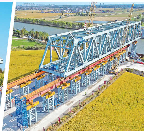
右幅钢桁梁精准落至横向滑轨上
