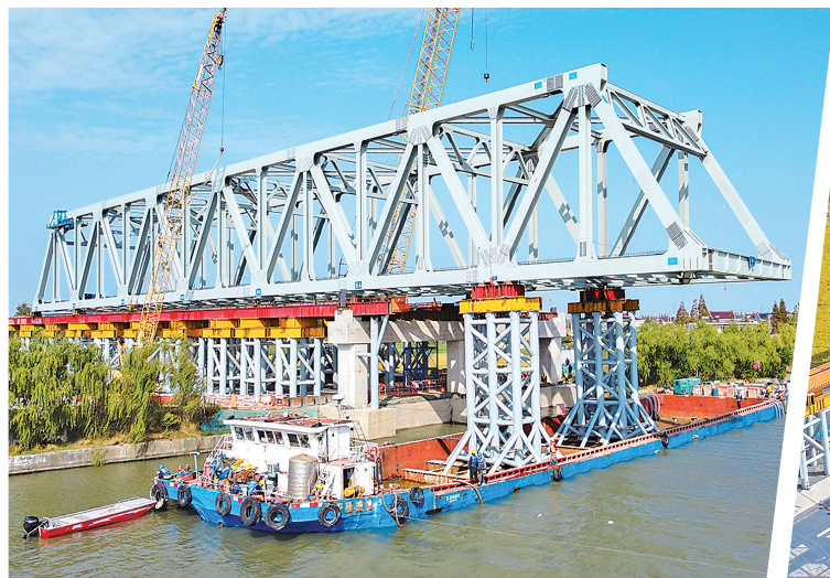
浮托船为钢桁梁提供了坚实的前支撑
