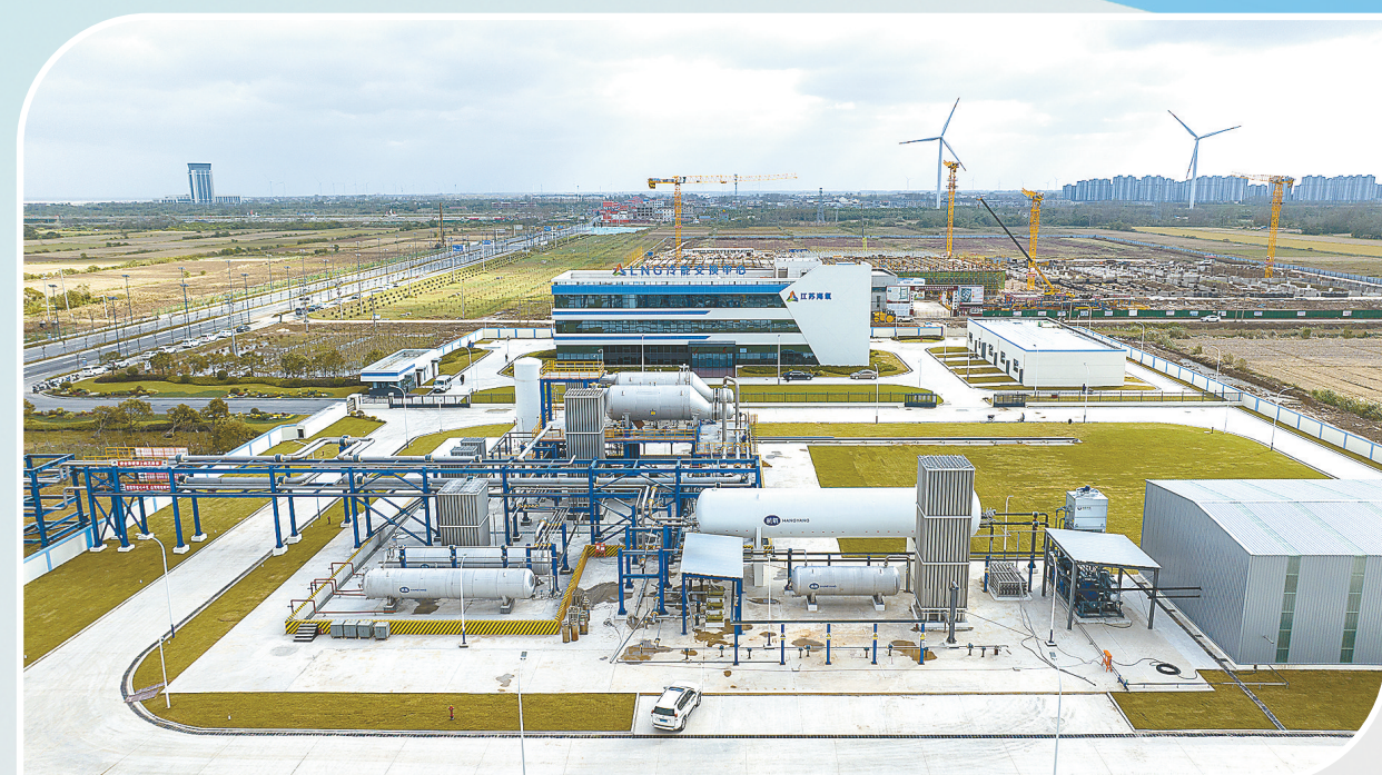
全国首家冷能交换中心——滨海港LNG冷能交换中心
