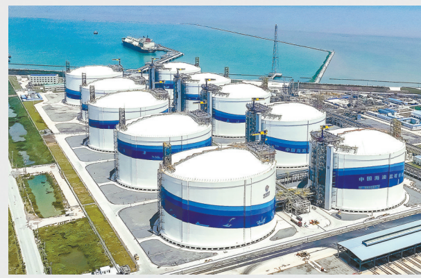
全国规模最大液化天然气储备基地——中海油滨海LNG接收站项目
