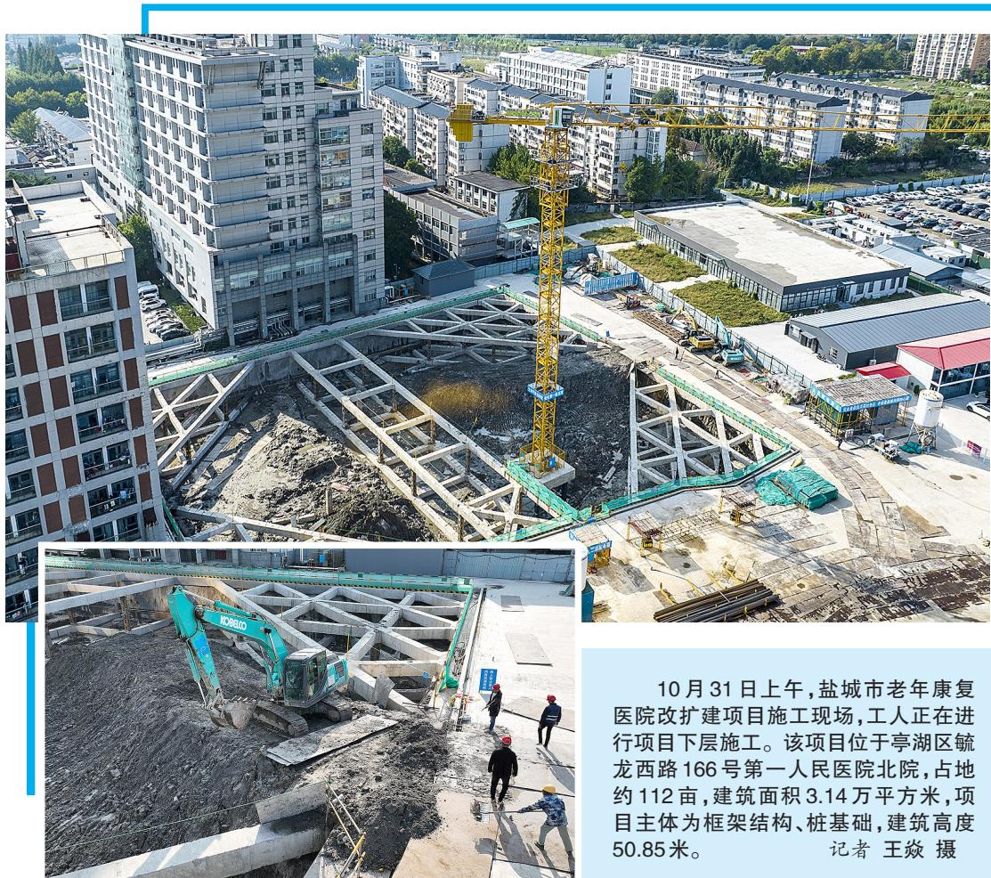
10月31日上午，盐城市老年康复医院改扩建项目施工现场，工人正在进行项目下层施工。该项目位于亭湖区毓龙西路166号第一人民医院北院，占地约112亩，建筑面积3.14万平方米，项目主体为框架结构、桩基础，建筑高度50.85米。
