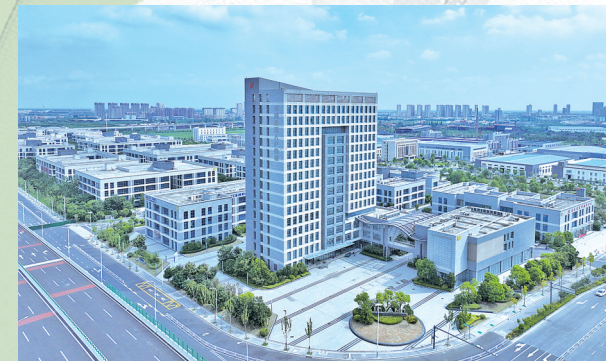
亭湖机器人产业基地
