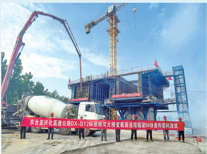
东兴高速通榆河大桥变截面连续箱梁0#块首件顺利浇筑
