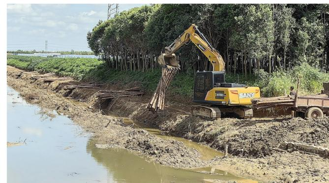
本报讯(董晓娟)9月9日,大丰区南阳镇广丰河,两台挖机正有条不紊地进行整坡、卸木头、打桩护坡等作业。
