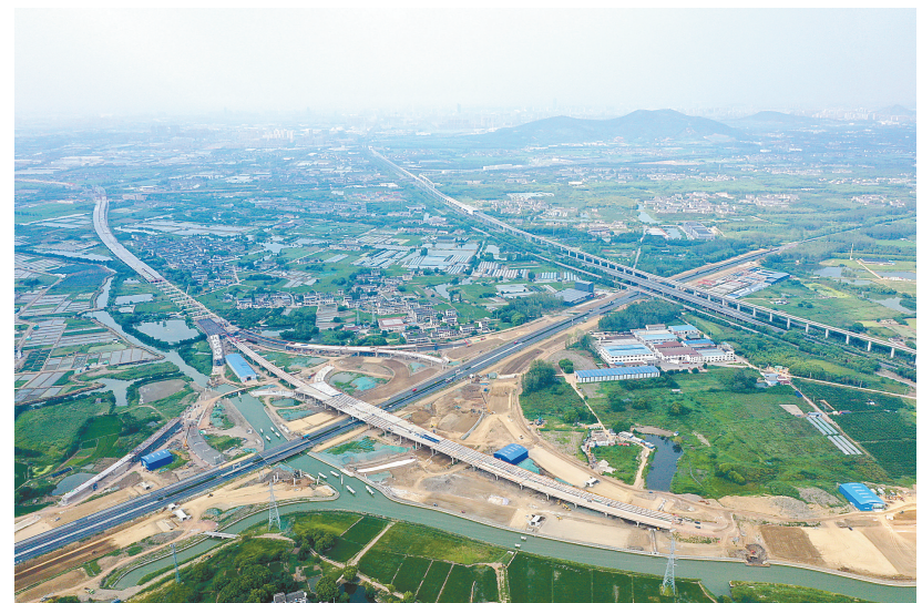
9月5日,沪武高速公路太仓至常州段扩建工程项目江阴段跨主线桥正在扩建施工中(无人机照片)。沪武高速公路太仓至常州段是沪武国家高速公路(G4221)的重要组成部分,目前,扩建工程全长134.865公里。全线采用两侧拼宽为主的总体扩建方案,浏河大桥北桥头至太仓枢纽段、董浜枢纽至常州南互通段由双向六车道扩建为双向八车道,太仓枢纽至董浜枢纽段由双向六车道扩建为双向十车道。
