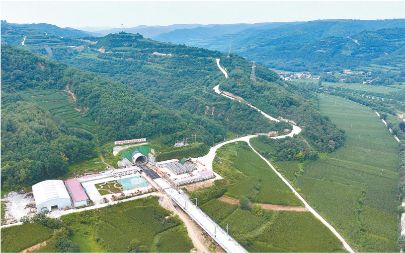
8月25日,由中铁三局承建的西(安)延(安)高铁武家塬隧道顺利贯通。武家塬隧道位于陕西省铜川市宜君县,全长约9.7千米。西安至延安高速铁路是陕北革命老区的首条高铁,也是国家高速铁路网包(银)海高速铁路通道的重要组成部分,建成投入运营后,西安至延安的铁路运行时间将从目前的2.5小时缩短至1小时左右。图为西延高铁武家塬隧道出口(8月25日摄,无人机照片)。
