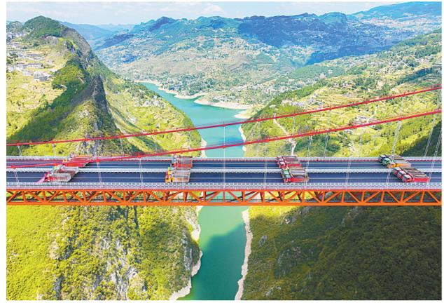
8月24日，大货车停放在桐梓河特大桥上进行荷载试验(无人机照片)。当日，由中铁广州局承建的贵州金(金沙)仁(仁怀)桐(桐梓)高速桐梓河特大桥开始进行荷载试验，数十辆大货车按照精密设计的方案停放在特定位置，模拟极端荷载下的桥梁状态，全面评估桥梁工作性能，确保其安全无虞。
