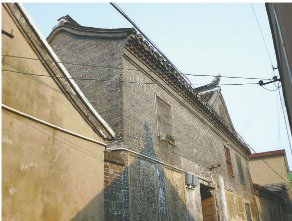
伍佑珠溪古镇完整保存下来的共和巷4号曾氏大楼
