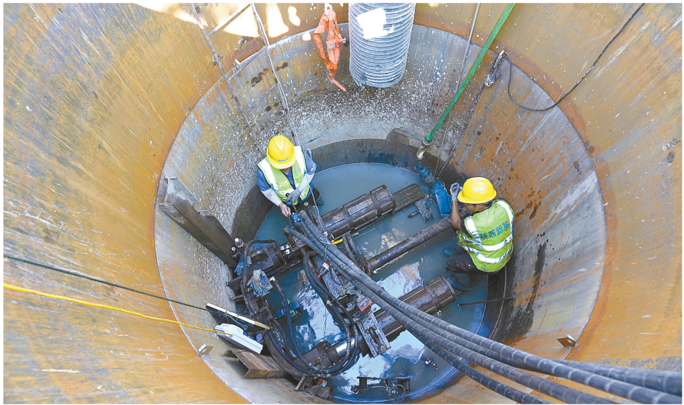
盐都区创智路微顶管施工现场
