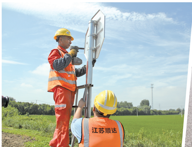
安装交通标志牌
