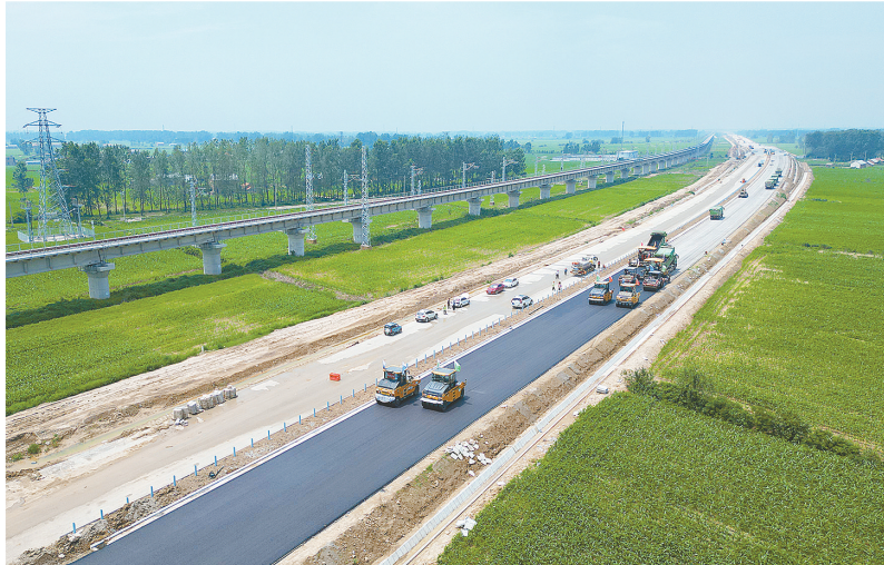
沥青摊铺作业是路面施工中最为“火热”的环节。为保证省重点工程——滨海高速公路盐城段建设进度的稳步推进，连日来，施工人员在双重高温的“烤”验下，用汗水诠释责任与担当。 记者 杨毅 通讯员 刘翔池 摄
