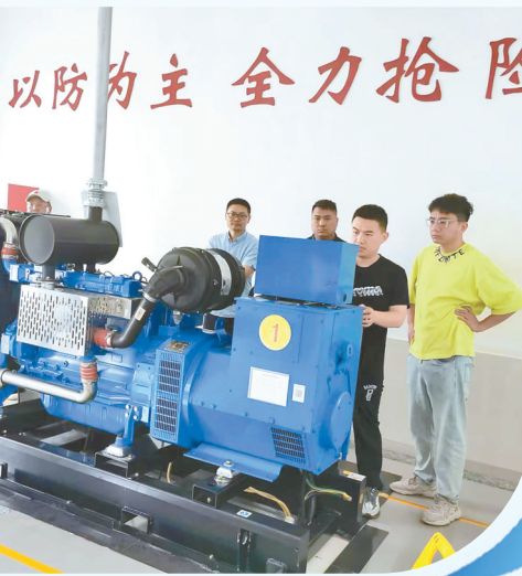
市斗龙港闸管理所组织停电应急发电演练
