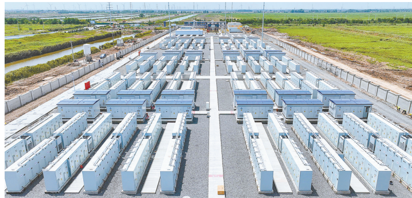
江苏沿海地区新型储能重点项目——三峡滨海储能项目位于滨海港工业园区，容量为200MW/400MWh，是首批纳入全省电力规划的电网侧储能项目，也是目前国内规模最大的采用组串式储能系统方案的储能电站。该项目具有电池性能均衡、安全性高、系统效率高、灵活性强以及全生命周期内度电成本低等特点，具有良好的技术性和经济性指标。
