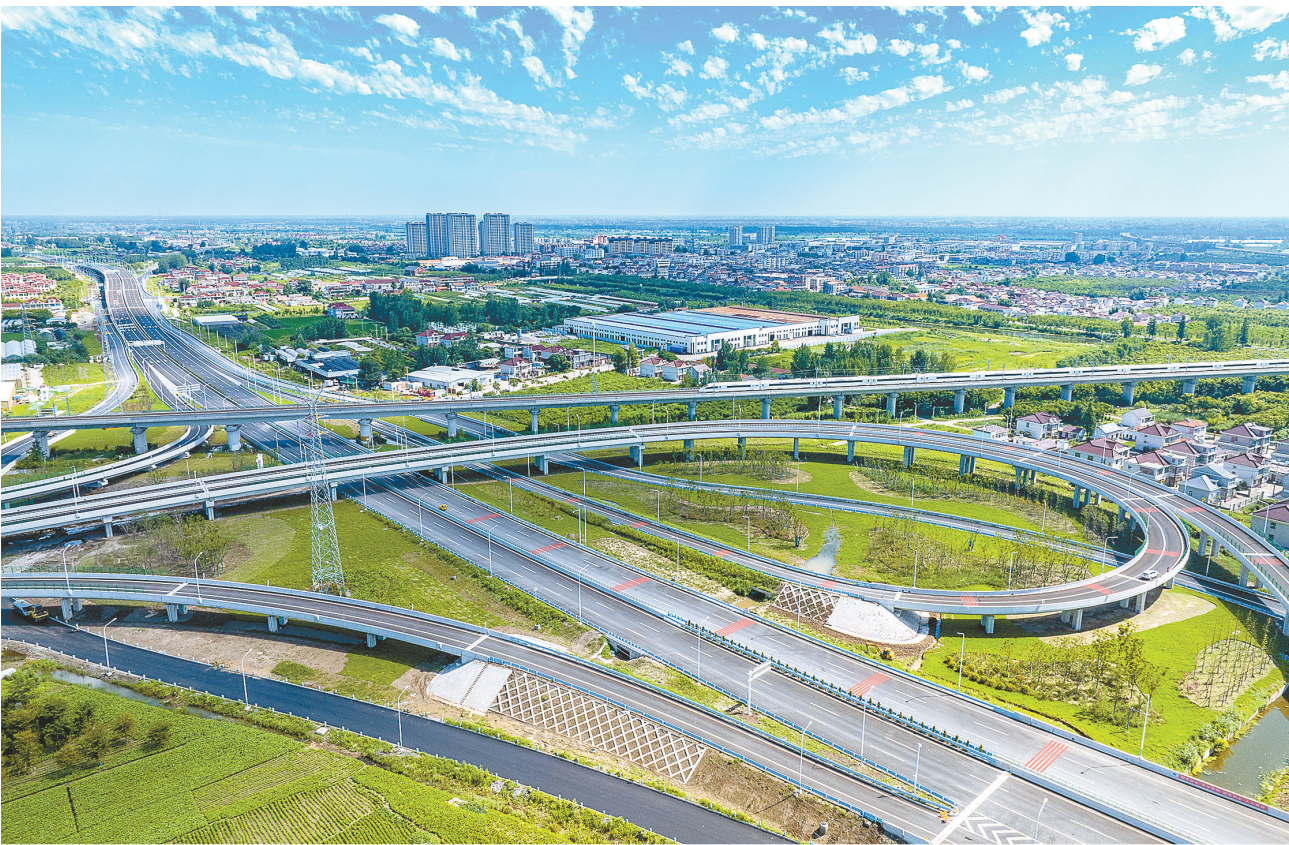
7月22日，盐阜快速通道三灶枢纽高架桥已进入护栏伸缩缝盖板安装阶段。该项目施工积极应对高温“烤”验，采取“干两头、避中间”的错峰施工措施，确保工程时效和安全生产两不误。
