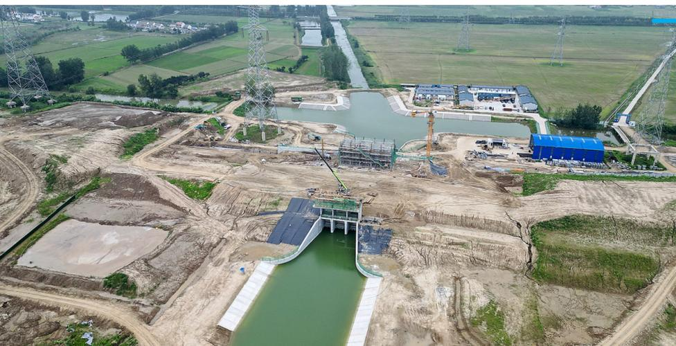
近日，在淮入海水道二期工程陶圩河闸站项目施工现场，工人正在闸站的站房进行脚手架搭设、钢筋绑扎、模板支立和水泵安装调试等工序的施工，现场一派繁忙。陶圩河闸站位于滨海县城东侧陶圩河与调度河交汇处，目前，水下工程完工，闸站已具备挡洪和应急排涝条件，预计9月底完成房建和附属配套工程。
