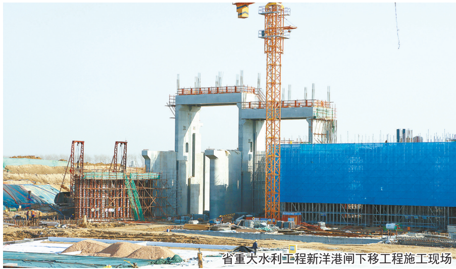
省重大水利工程新洋港闸下移工程施工现场
