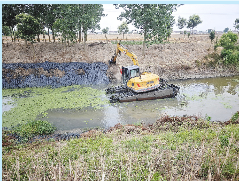
近日,大丰区小海镇积极开展沟渠清淤疏浚工作,对条排沟和灌溉渠道进行清淤,疏通农业“命脉”,开启泵站翻水供水,确保农田灌溉用水畅通,助力粮食增产增收。截至目前,小海镇启动灌溉泵站103座,出动机械104台(套),清理条排沟30条,2.8公里。 陈少忠 王红丽 摄
