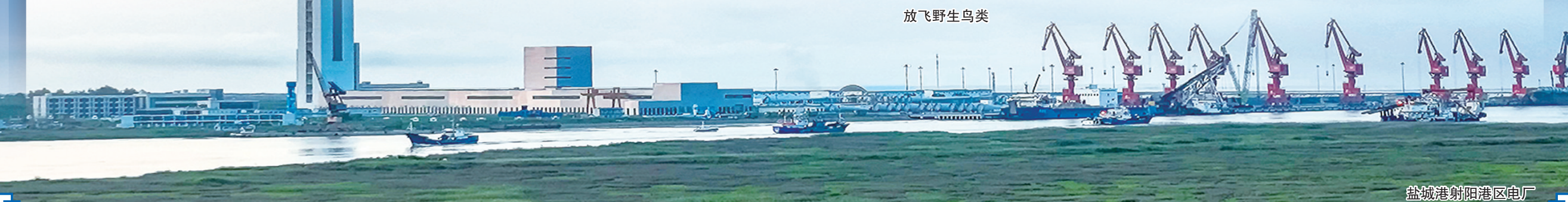
盐城港射阳港区电厂
