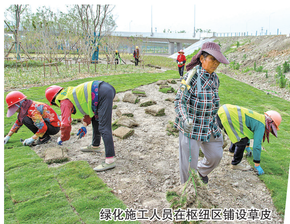
绿化施工人员在枢纽区铺设草皮
