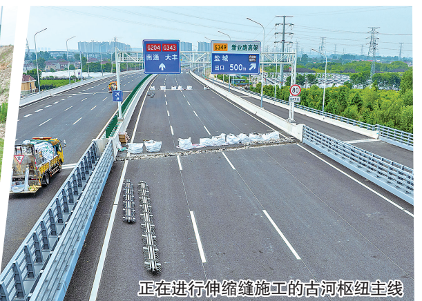
正在进行伸缩缝施工的古河枢纽主线
